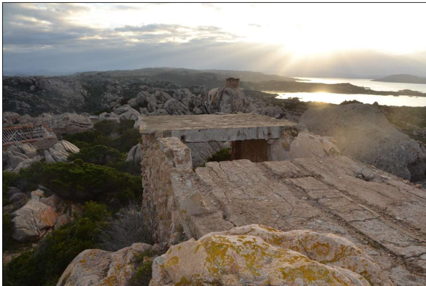
Fig. 3 – Veduta panoramica delle strutture
