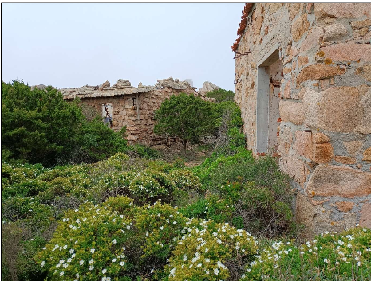
Fig. 28 – Area di cantiere
