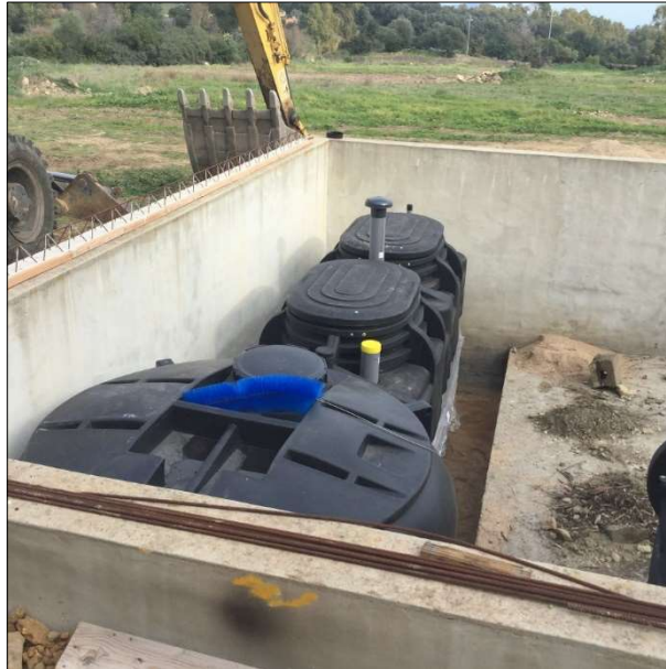
Fig. 29 – Esempio di impianto di depurazione
